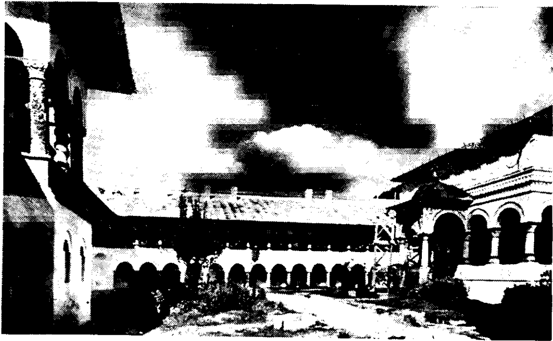
Mănăstirea Hurezu. Vedere din interiorul incintei
