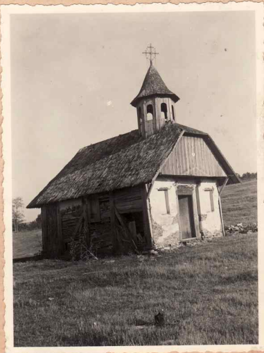
2. (776) Vedere dinspre nord-vest
