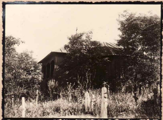
2. Vedere dinspre sud-vest
