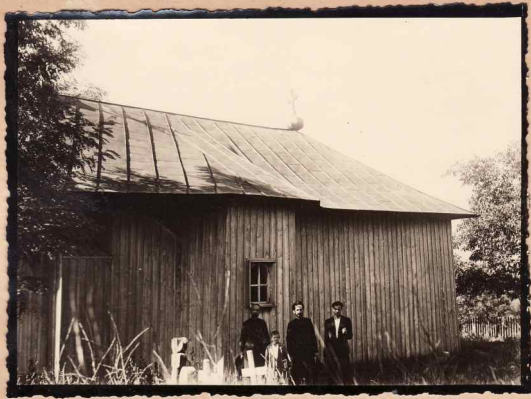
1. Vedere dinspre sud. a bisericii din vălătuci căptușită cu scânduri
