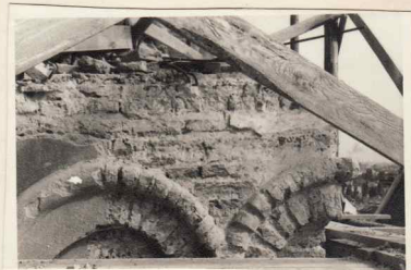
44. A. Detaliu de cornișe vechi dela baza pătrată a turlei mici pronaos sud 43. Detaliu de baza turlei mari a pronaosului.
