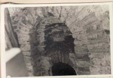
40.A. Detaliu de fereastră navă dela turla mare a pronaosului
