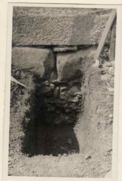
11. Biserica - sondaj pe la- tura de sud - vederea funda- țiilor.
