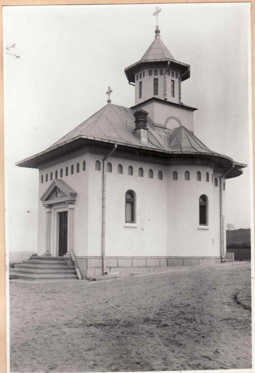
1. Vedere dinspre sud-vest
