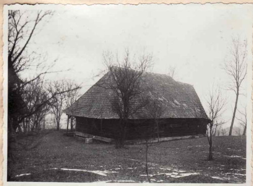
2. Fațada sud - V.
