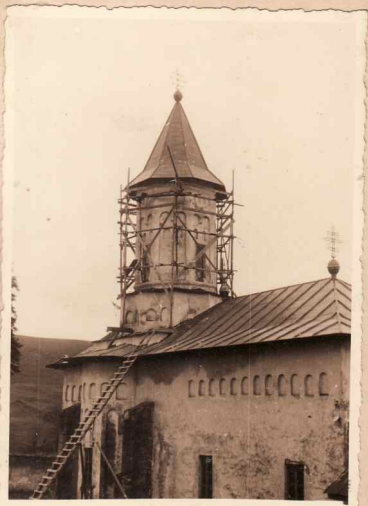
1. Vederea bisericii dinspre nord în timpul restaurării
