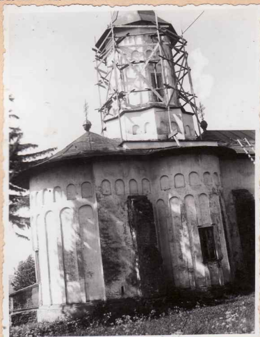
1. Vedere în cursul restaurării acoperișului, scoțându-se la iveală baza pătrată N-E.
