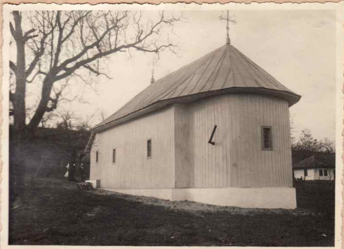
1. Vedere dinspre sud-est
