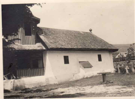
1. Vedere dinspre sud-vest ,pronaos din paiantă, aduss
