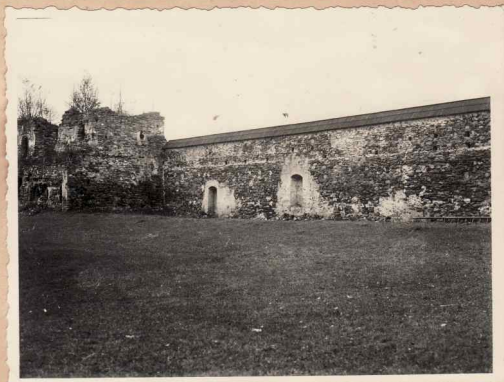
2. Zid de înprejmuire pe latura nord și ruinel fostei (stăreții) clădirii
