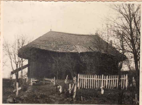
1. Vedere dinspre sud-vest
