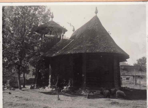
4. Vedere dinspre sud-est
