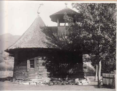
3. Vedere dinspre nord-est
