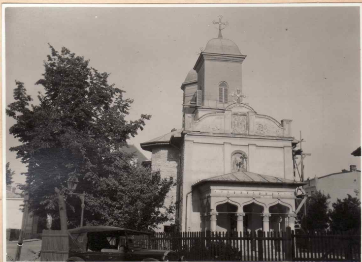
1. Vedere dinspre vest înainte de restaurare
