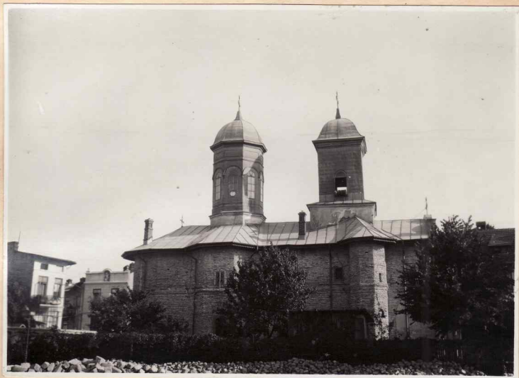
1. Vedere dinspre nord înainte de restaurare
