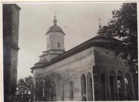
3. Vedere dinspre nord-vest
