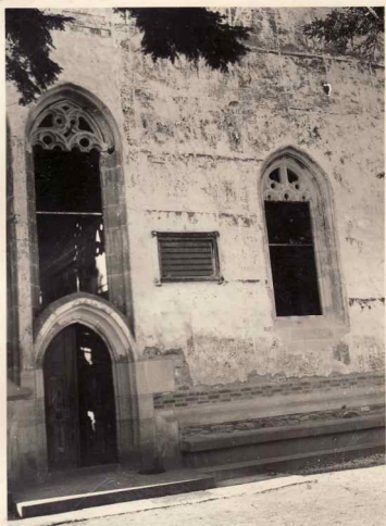
1. Fațada sud. Ușa pridvorului și o fereastră a pronaosului
