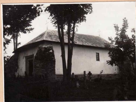
1. Vedere dinspre sud-vest a bisericii din paiantă (lemn și cărămidă) Contraforții sînt adăugați
