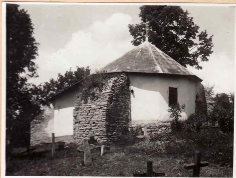
2. Contraforți și soclu adăugați, vedere dinspre sud-est
