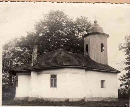
1. Vedere dinspre nord-est
