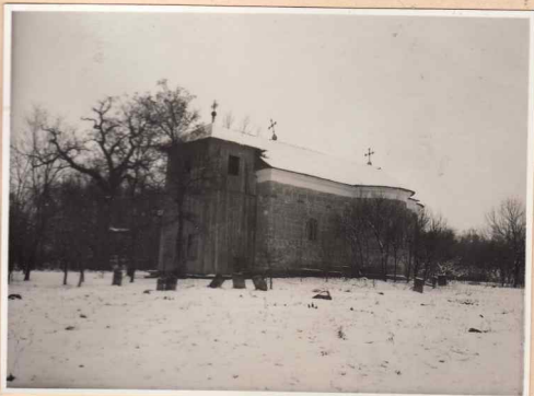
2. Vedere dinspre sud-vest
