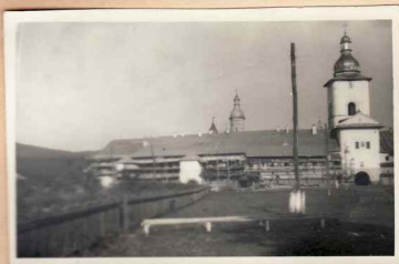
44. Latura vest a incintei (exterior) în timpul șantierului
