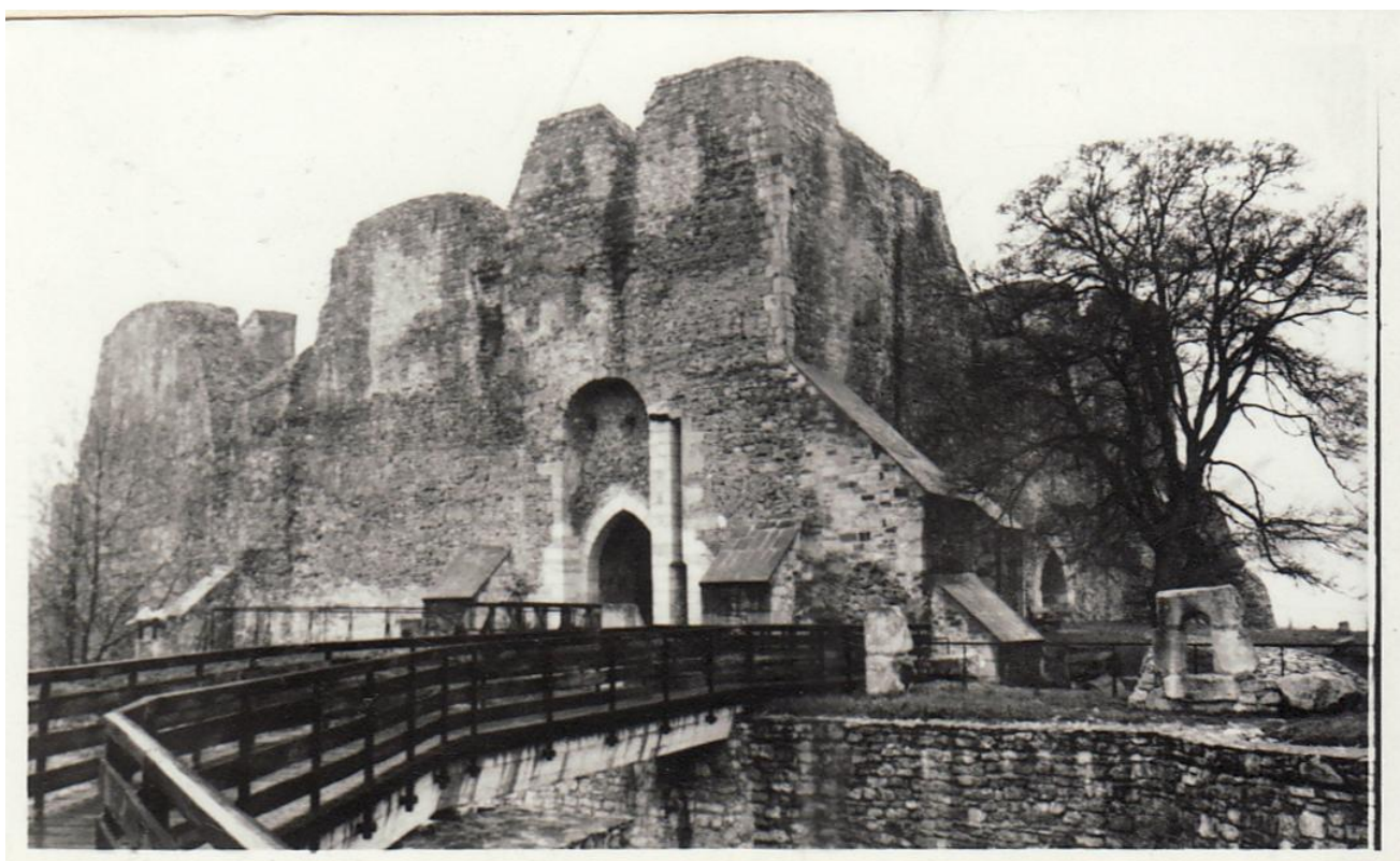
5. Vedere dinspre nord-est – autor S. Machedon 1973.
